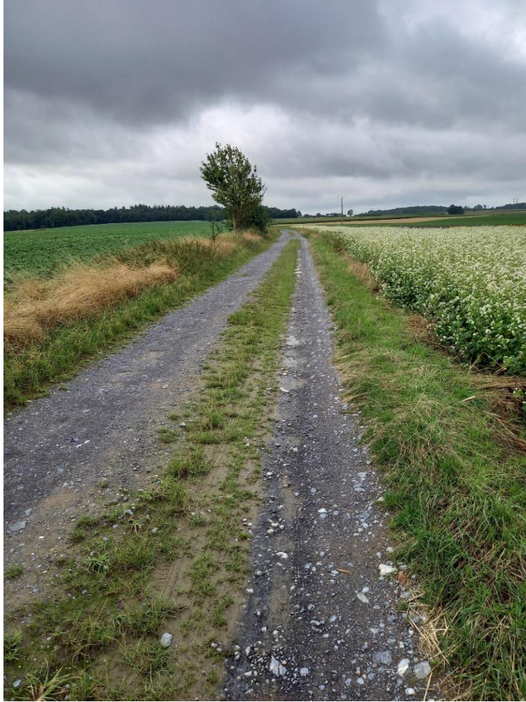
Figure 7-17 Prise de vue 11 du chemin d'accès situé le long de la parcelle à remblayée (orientation Sud)
