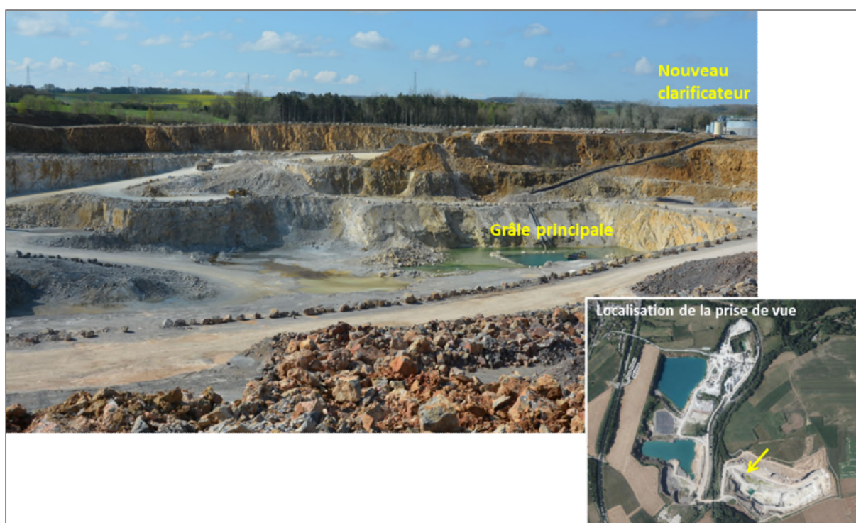
Figure 197 : Vue de la fosse sud-est (ARIES, avril 2023)
