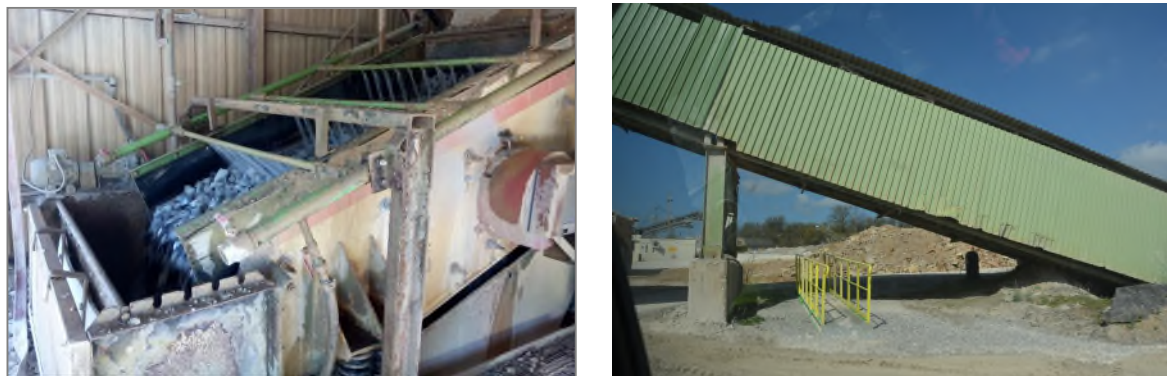
Figure 332 : Traitement des granulats par aspersion sous pression et bardage des installations de transport des matériaux (ARIES, 2023)
