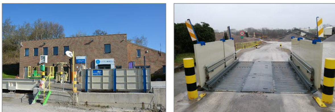
Figure 157 : Vue sur la zone de pesage et de nettoyage des roues des camions à la sortie de la carrière (ARIES, 2023)
