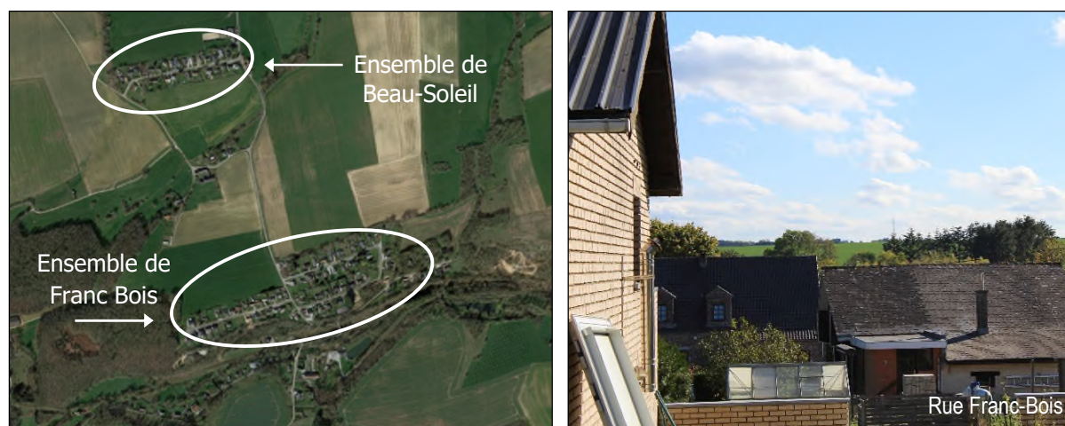
Figure 39 : Vue du tissu urbain (2023) et du cadre bâti des ensembles de Franc Bois et de Beau-Soleil (ARIES, 2018)
