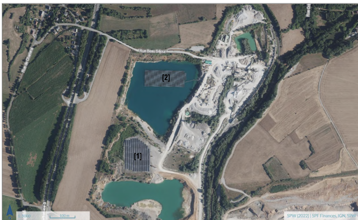
Figure 322 : Localisation des champs de panneaux photovoltaïques (ARIES, sur fond WalOnMap, 2023)
