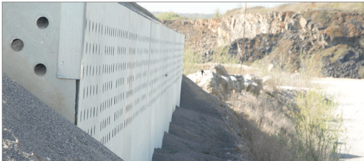
Figure 286 : Falaises artificielle à Hirondelles de rivage – Occupée en 2023 (ARIES, 2023)
