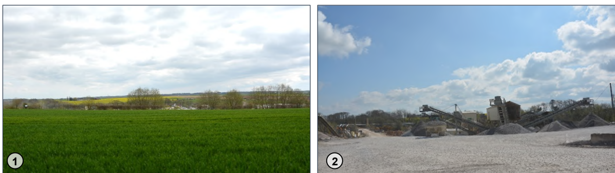
Figure 42 : Vues sur les installations depuis l'extérieur (N5) et depuis l'intérieur du site (ARIES, 2023)
