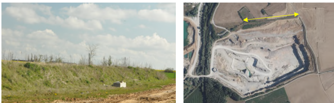
Figure 303 : Vue depuis le haut du merlon d'isolement nord-est (ARIES, 2023)
