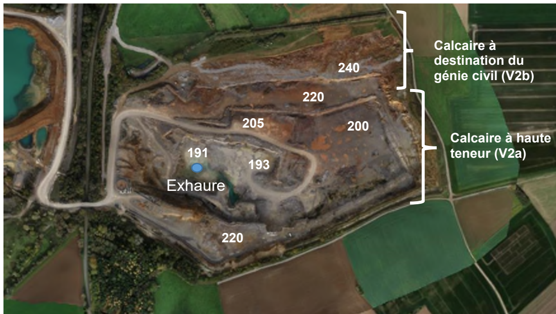
Figure 201 : Photo aérienne de la fosse en activité - février 2023 (Carrières "Les Petons", 2023)
