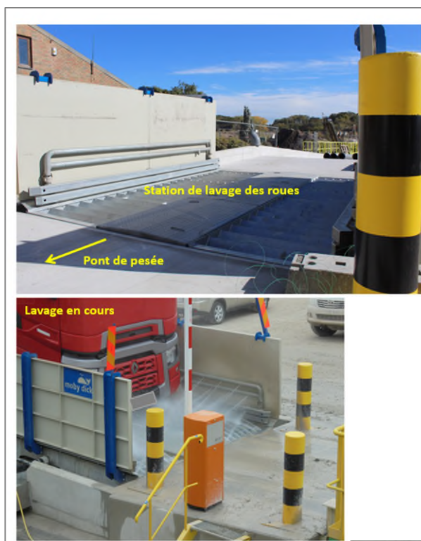
Figure 269 : Station de lavage des roues (ARIES, 2023)
