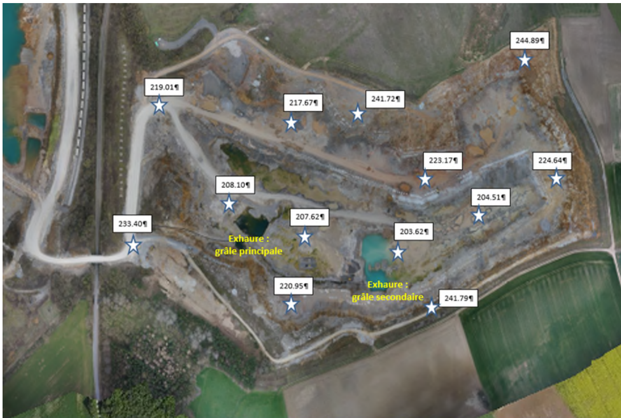
Figure 200 : Aperçu de la fosse sud-est en avril 2019. Les cotes altimétriques rapportées sont obtenues à la suite d'un levé par drone (Carrières "Les Petons", 2023)
