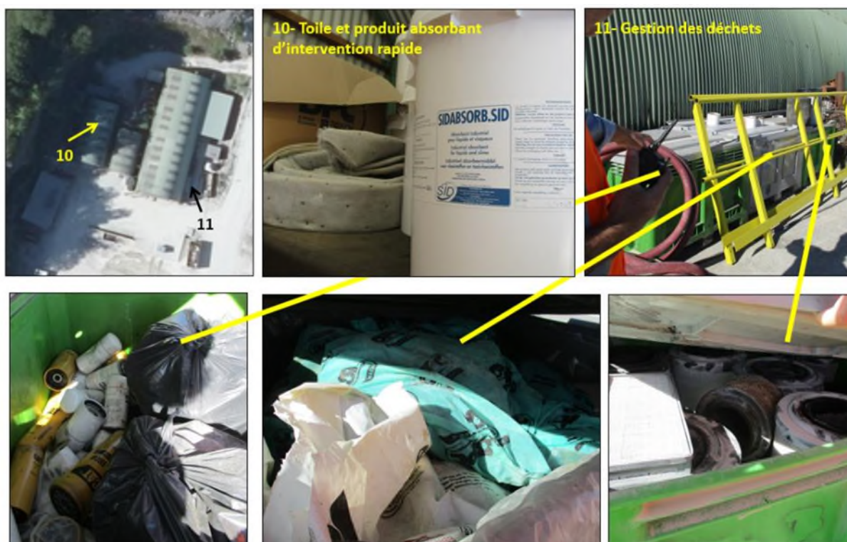
Figure 225 : Zone « atelier » à l'ouest du bassin tampon : kit d'intervention rapide et conteneurs pour la gestion des déchets dangereux (WalOnMap et ARIES, 2019)
