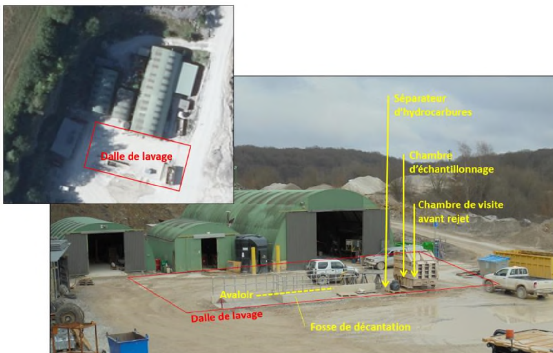
Figure 227 : Dalle de lavage dans la zone d'atelier exploitée par les Carrières "Les Petons" (WalOnMap et ARIES, 2019)
