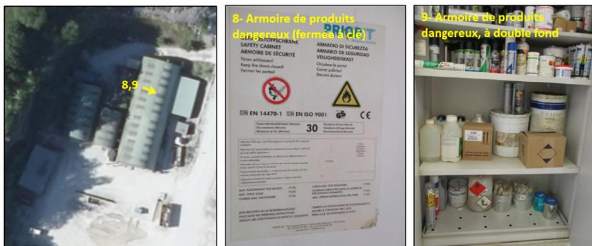
Figure 224 : Atelier à l'ouest du bassin-tampon d'eaux claires : armoire de produits dangereux en petits conditionnements (WalOnMap et ARIES, 2019)
