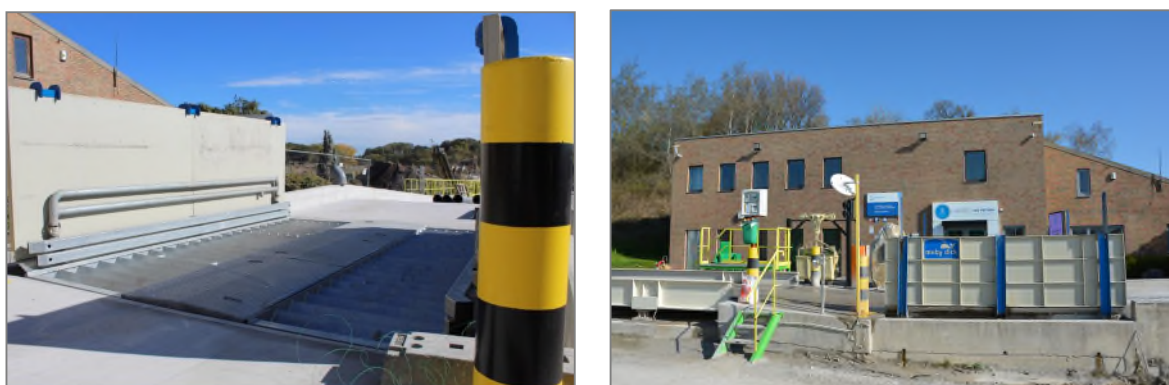
Figure 331 : Vue sur la nouvelle station de lavage des roues des camions en sortie de site (ARIES, 2023)
