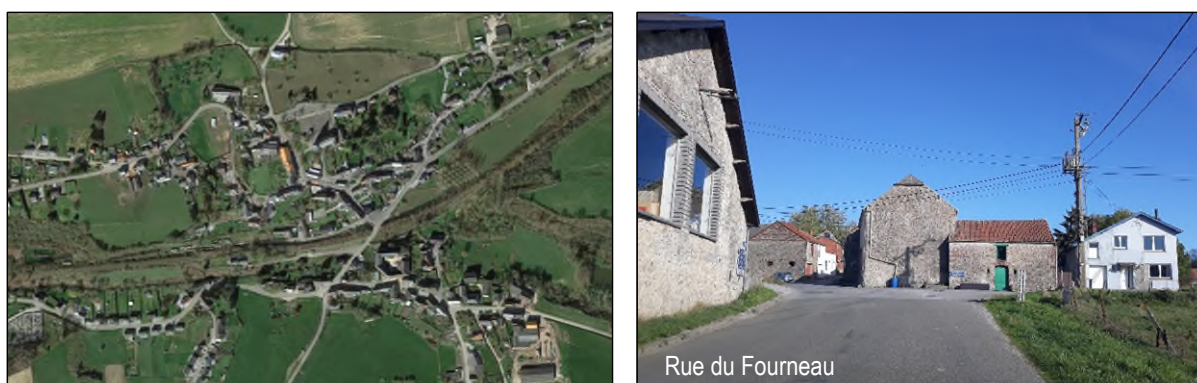
Figure 32 : Vue du tissu urbain (2023) et du cadre bâti de Saint-Aubin (ARIES, 2018)
