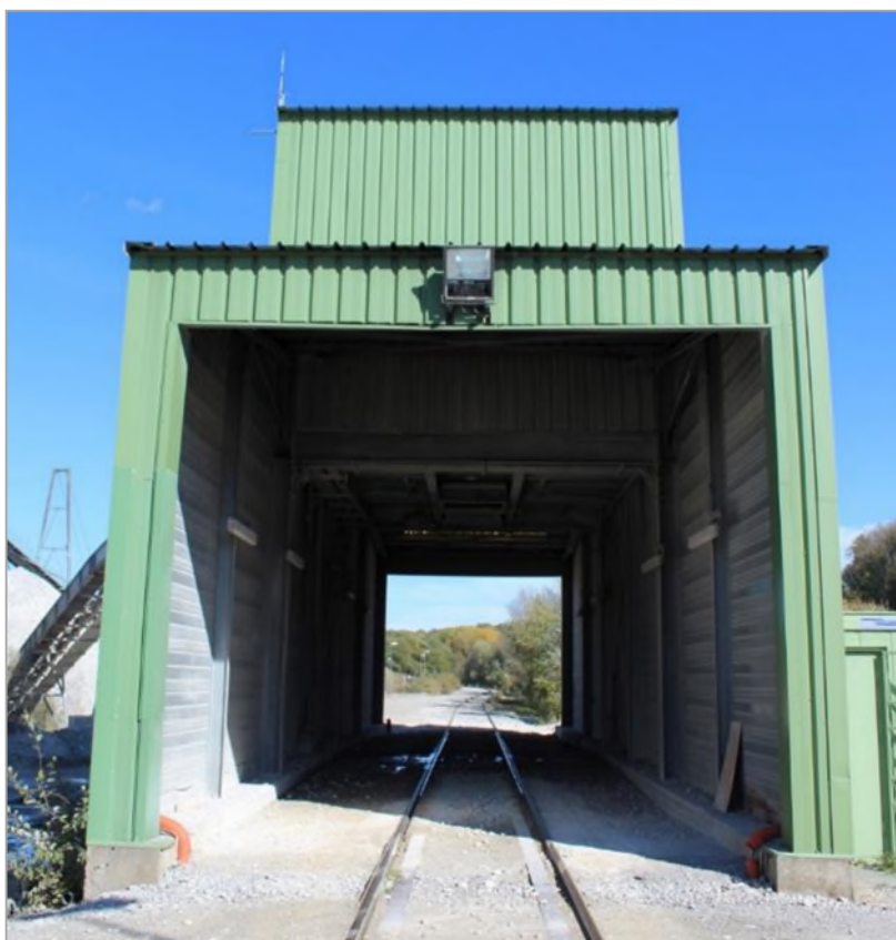
Figure 333 : Vue sur la station de chargement des trains (ARIES, 2023)
