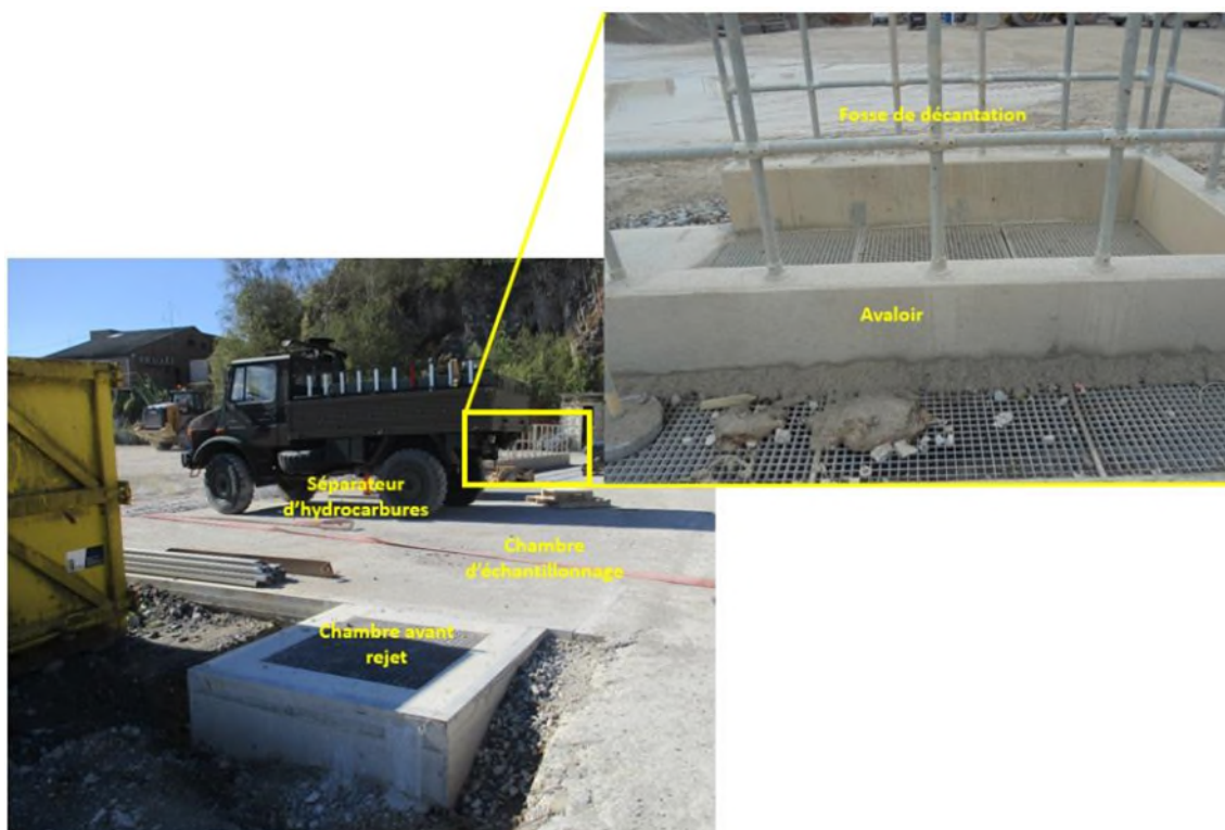
Figure 228 : Dalle de lavage dans la zone d'atelier exploitée par les Carrières "Les Petons" (ARIES, 2019)
