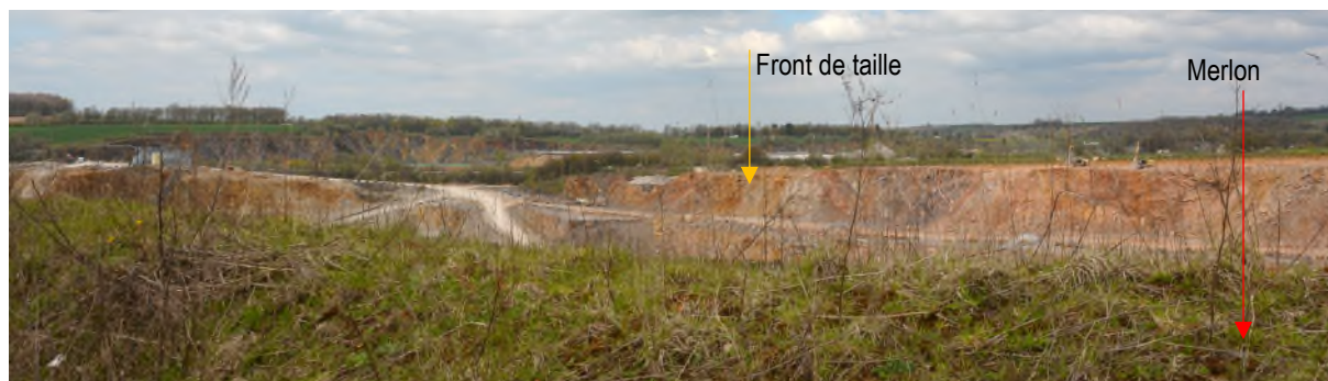
Figure 90 : Vue sur le merlon existant et identification de la perception du front de taille (ARIES, 2023)
