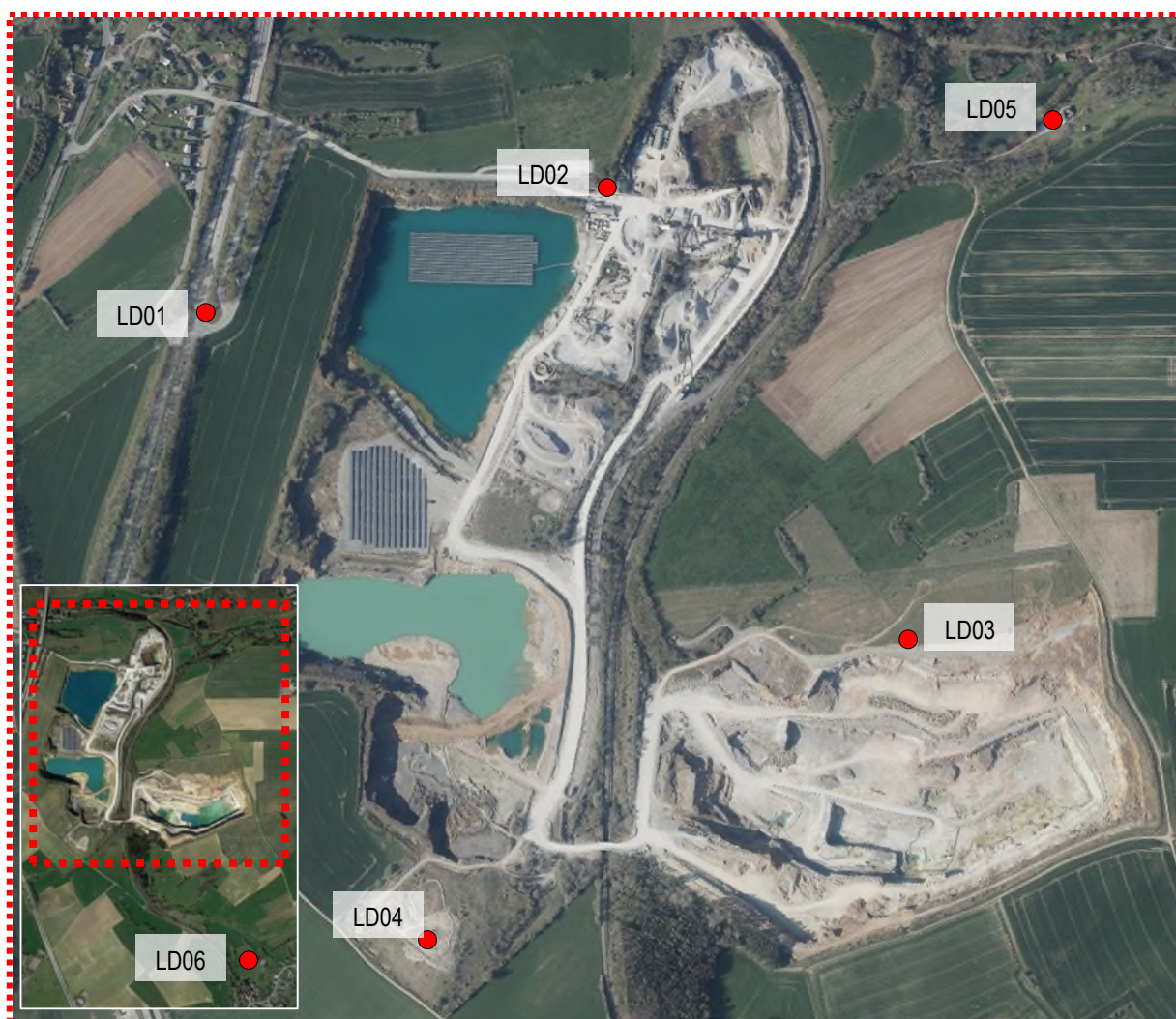
Figure 359 : Localisation des points de mesures acoustiques de longue durée (ARIES sur fond Google, 2023)
