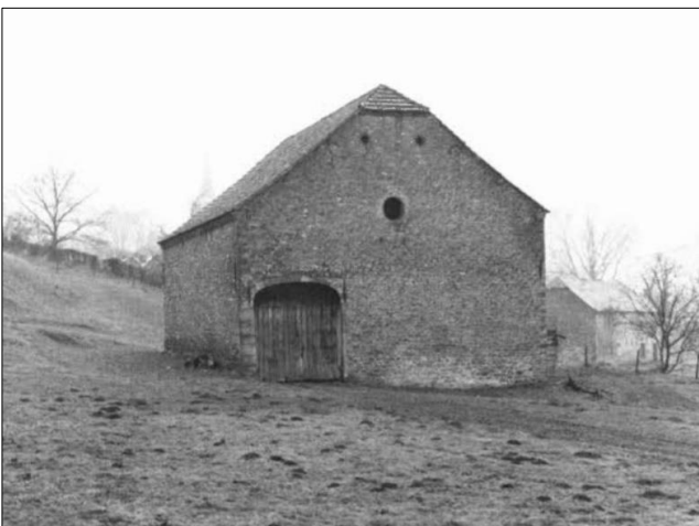
Figure 70 Grange rue Martia à Berzée
