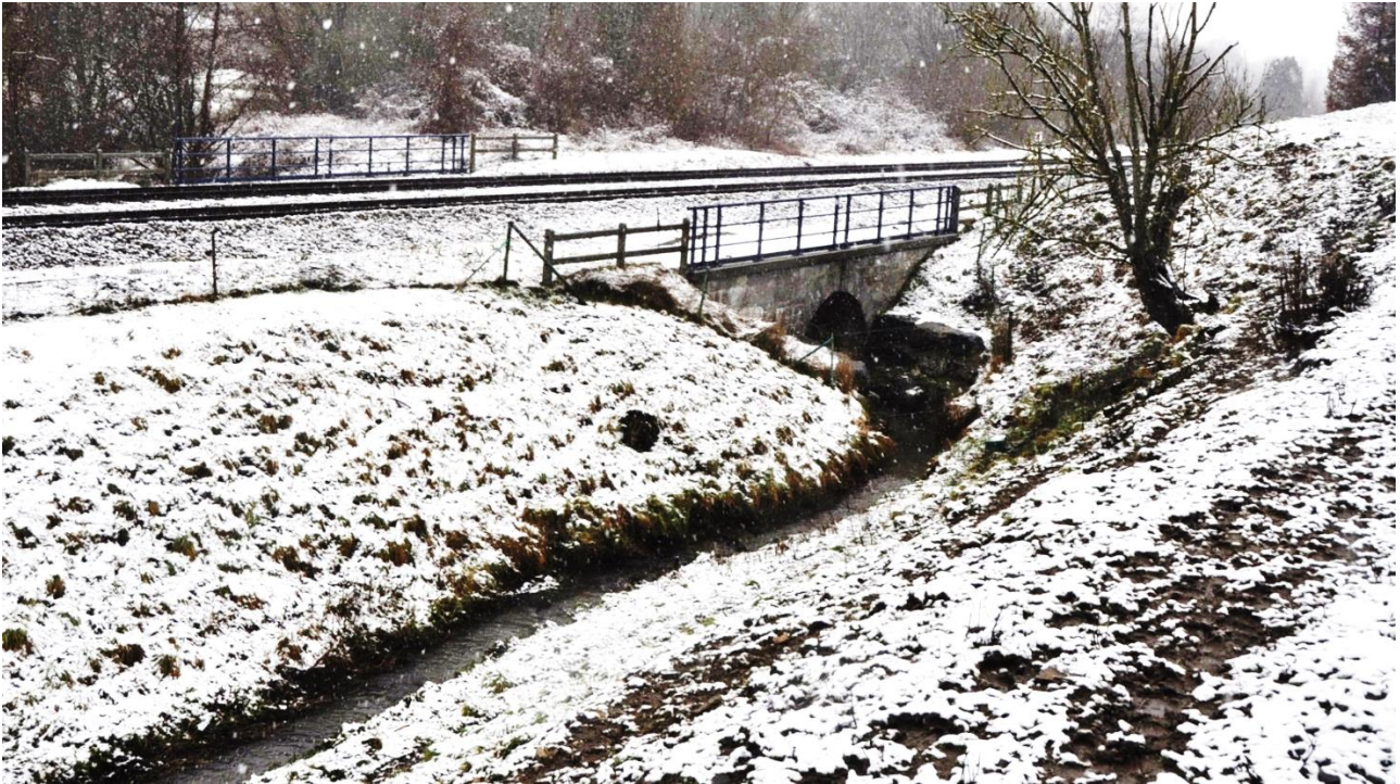
Figure 43 Fossé du Thyria passant sous le chemin de fer (Source : CSD, 2019)
